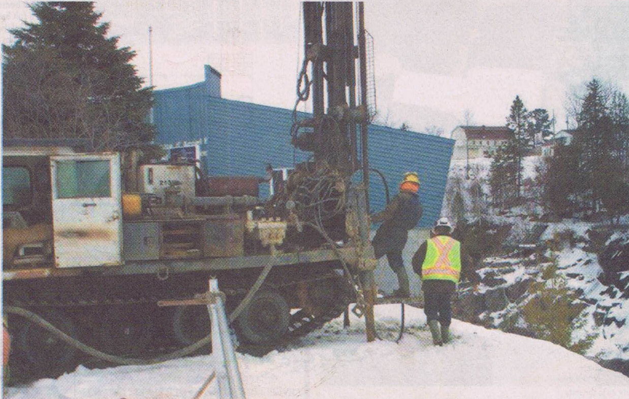
Forage à travers les rochers
